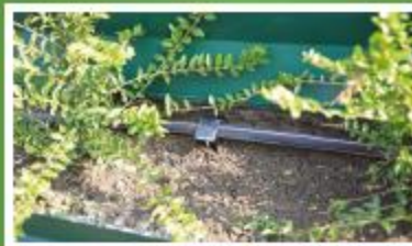
Tuyau goutte à goutte avec répartition exacte et efficace de l'eau.
