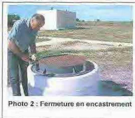
Photo 2 : Fermeture en encastrement
