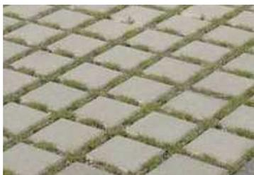
Utilisation de matériaux perméables sur les surfaces de stationnement
