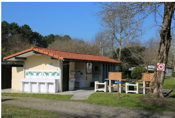
Installation en dur
