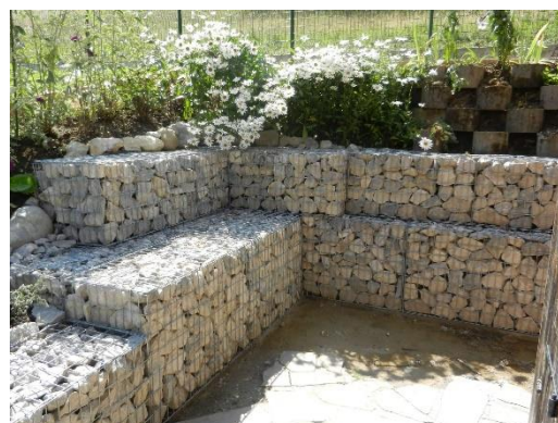
Muret de gabions
