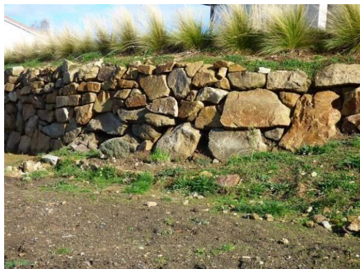
Muret de pierres sèches
