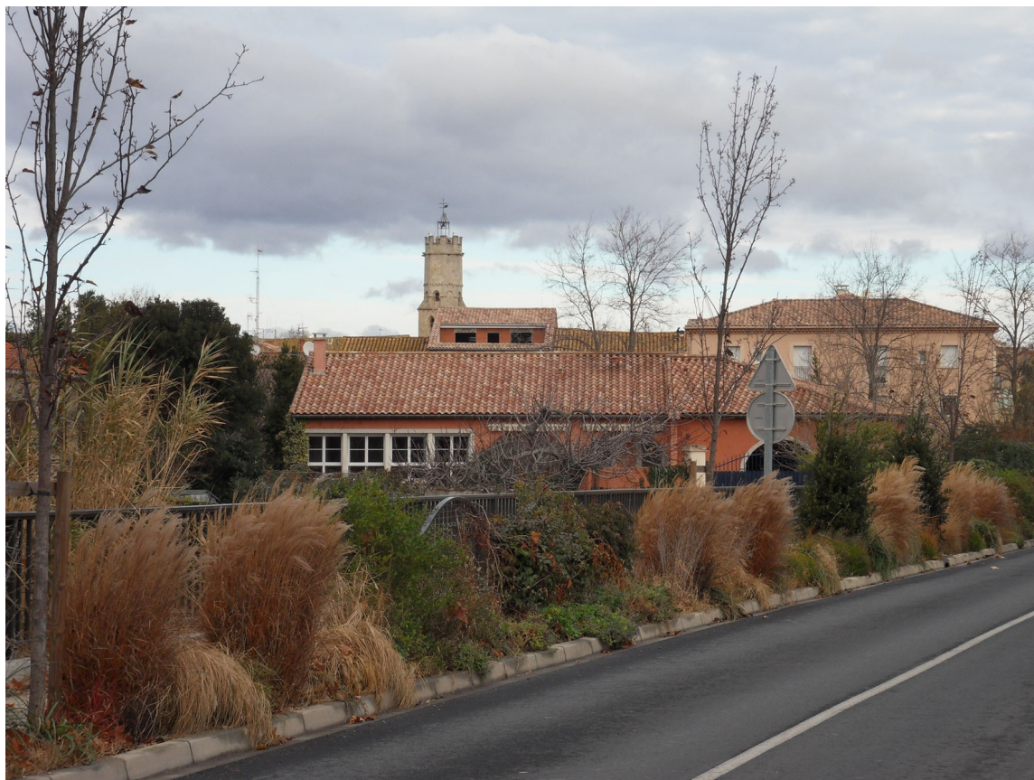
Photo 20 – Vue depuis la RD37 – Impact d'une surélévation
