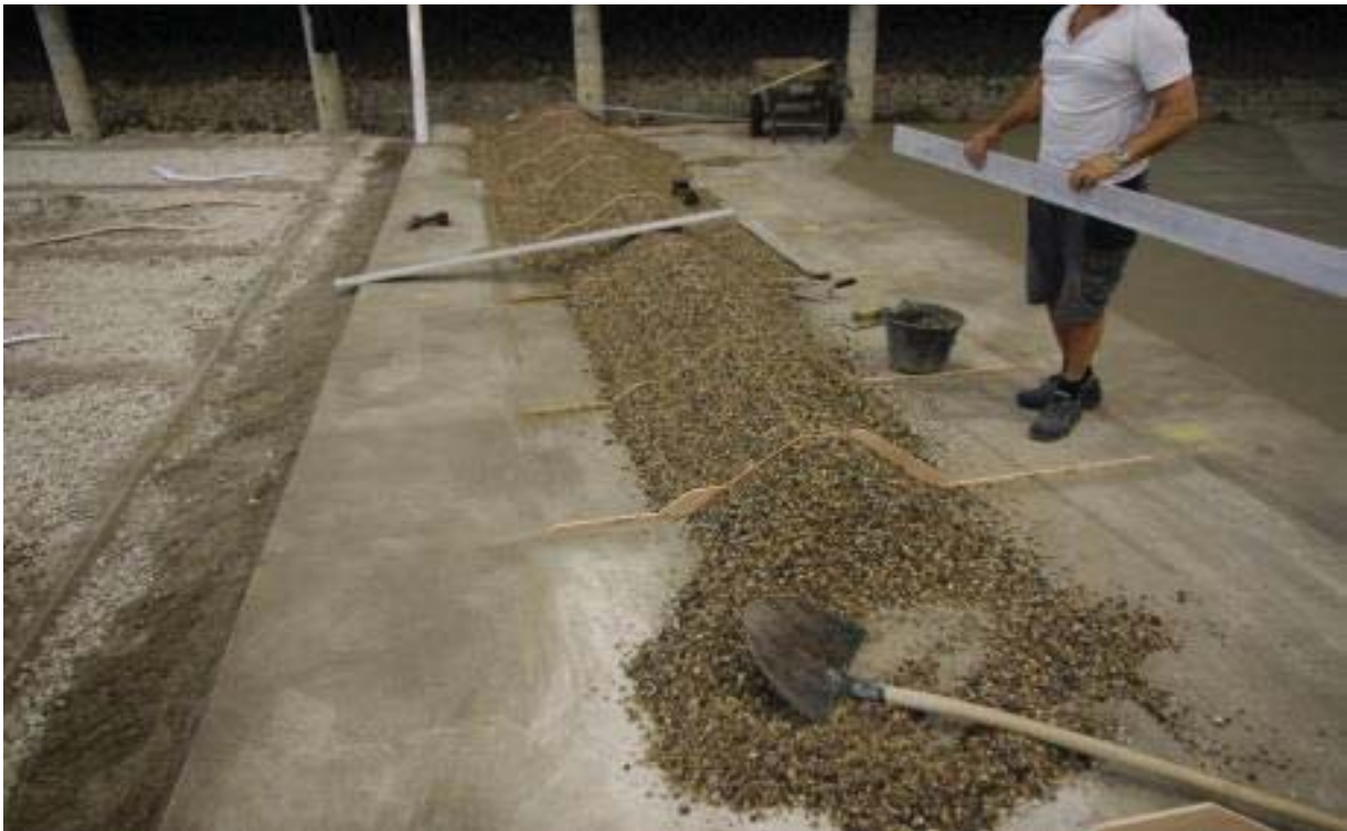
Etape 4: Le noyau de la digue est mis en place
