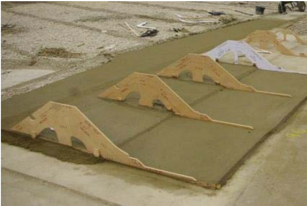
Etape 3: Début de construction de la digue avec mise en place des gabarits
