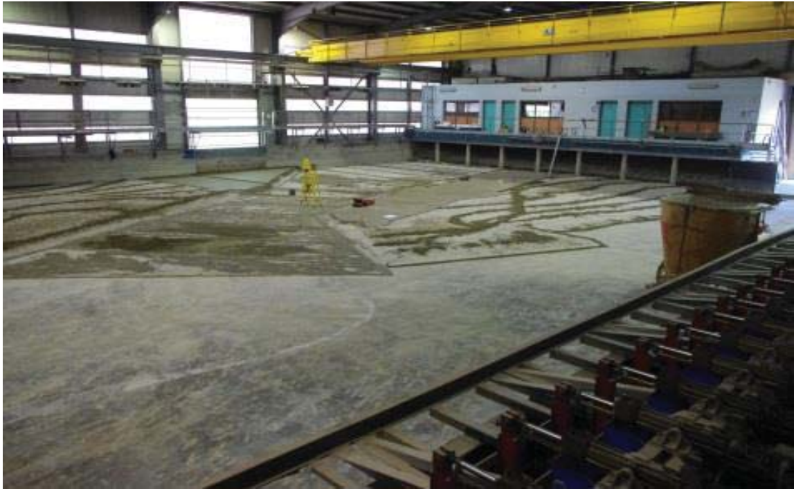
Etape 2: Remplissage par des gravettes et début de construction des fonds (chape béton)
