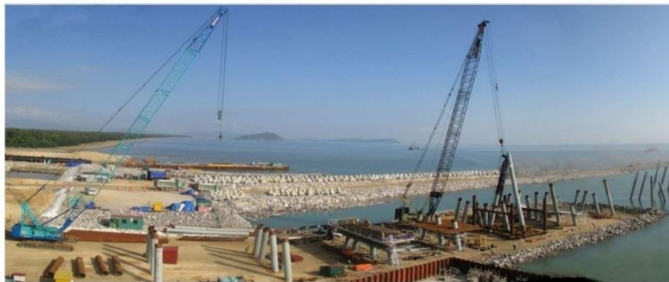
Figure B - 40. Exemple de battage de pieux (postes tankers – Nghi Son (Vietnam))
