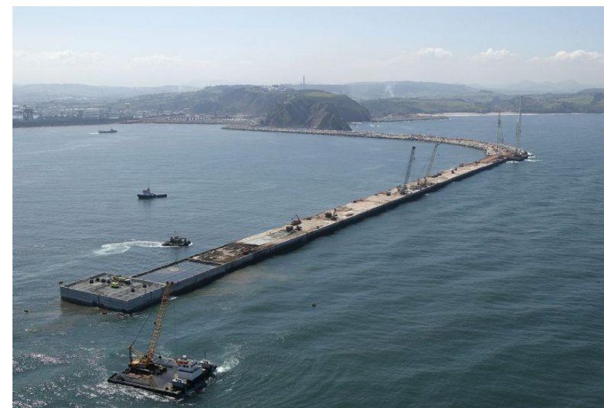
Exemple de digue mixte (digue à talus jusqu'à -20m et caissons au-delà - Port de Gijon - Espagne)
