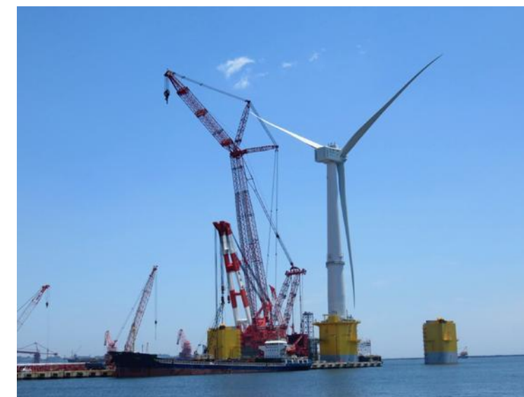
Figure B - 31. Mise en place de l'éolienne sur le flotteur (port de Onahama – Japon)
