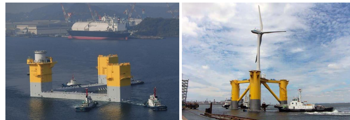
Figure B - 10. Exemples de flotteurs acier – Installation au large de Fukushima (Japon)
