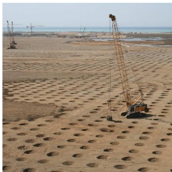
Figure B - 81. Compactage dynamique
