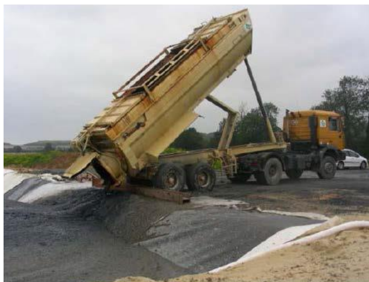
Figure B – 66. Camion étanche déversant des sédiments sur le site de stockage
