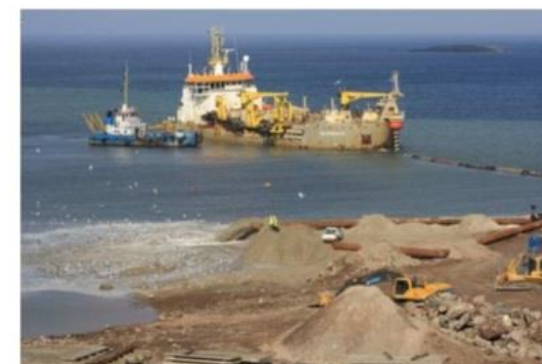
Figure B - 77. Mise en place d'une digue d'enclosure et conduite de refoulement dans un casier
