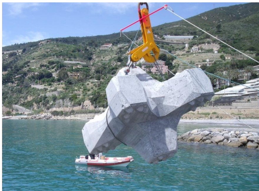
Mise en place – Bloc ACCROPODE™II (Ospedaletti – Italie)
