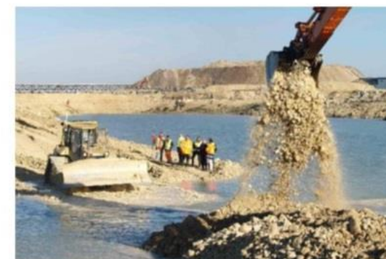
Figure B - 76. Figure schématisant le remblaiement hydraulique
