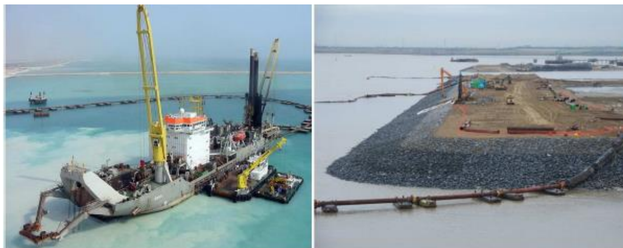
Figure B - 78. Refoulement par DAM ou DAS : création des terre-pleins
