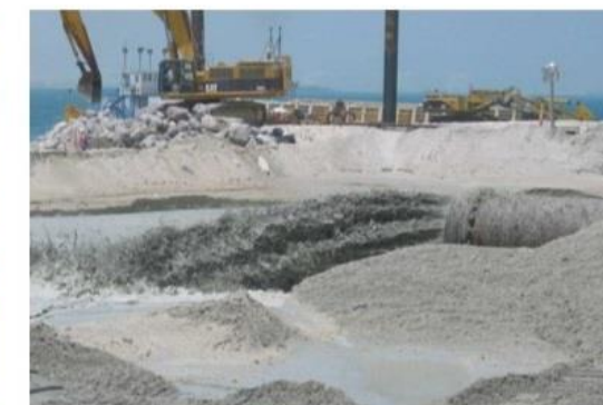
Figure B - 77. Mise en place d'une digue d'enclosure et conduite de refoulement dans un casier
