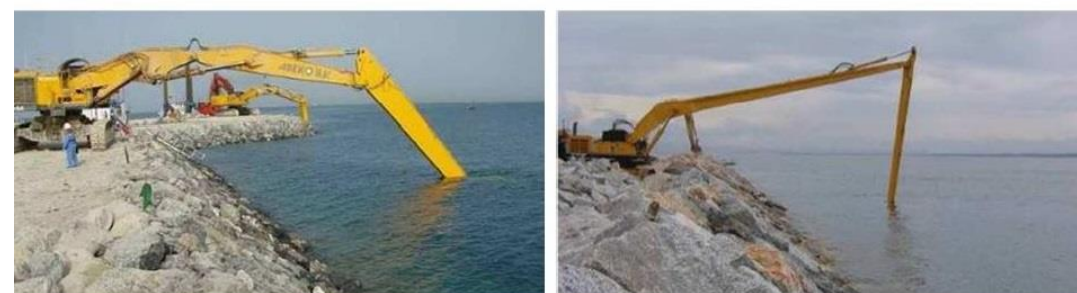
Exemple de mise en place d'une sous-couche à l'aide d'une pelle mécanique de grande portée
