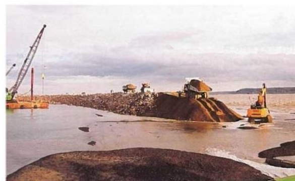
Exemple de mise en place du noyau déversé par tombereau (chantier de port 2000)
