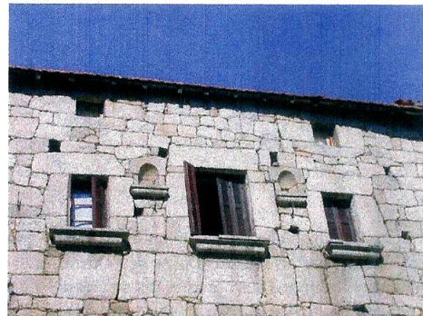
Forciolo – Détail des fenêtres de l'étage noble. Les appuis monolithes sont sculptés. Les pierres des allèges posées de champ présentent des faces approximativement carrées.
