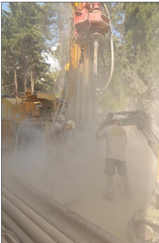
Photographie 2 : Foration au marteau
