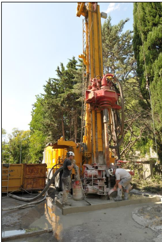
Photographie 1 : Foration au rotary
