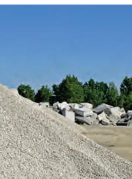
Granulats recyclés (1 er plan) produits à partir du concassage des bétons de démolition (2 nd plan)
