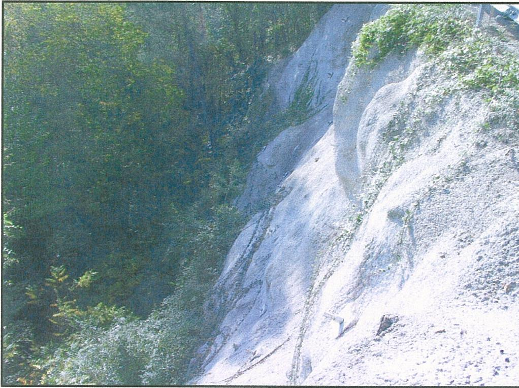
**Photographie 3.** Ancrages et béton projeté du confortement du glissement sous le chemin de l'escure.
