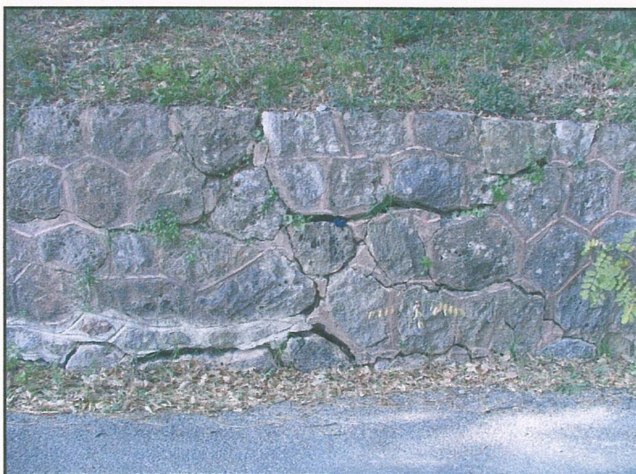
**Photographie 2.** Exemple de mur ayant subi une poussée de terrain.
