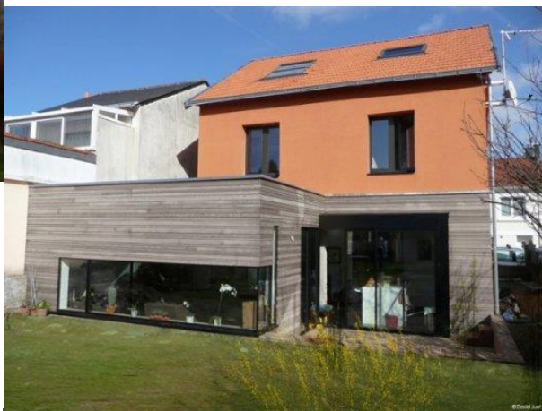
Construction principale autour de 35^\circ et extension récente en toiture plate
