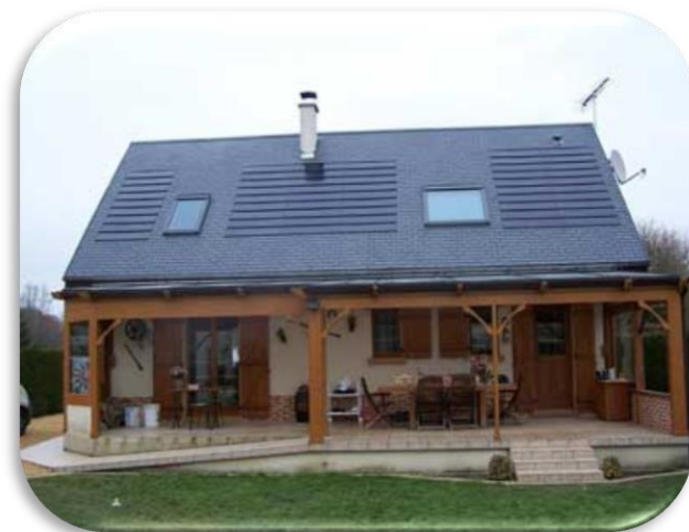
Ardoise photovoltaïque : excellente intégration
