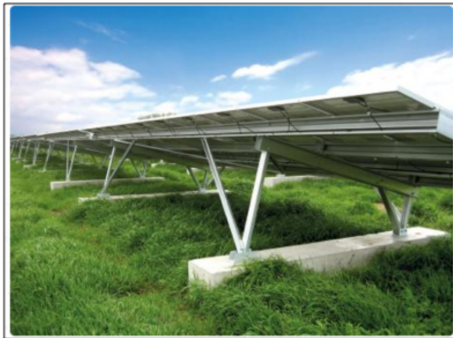
Exemples de panneaux photovoltaïques installés sur structures fixes lestées Source REDEN Solar 2018
