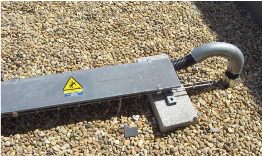
Chemin de câbles lesté et capoté - Source REDEN Solar
