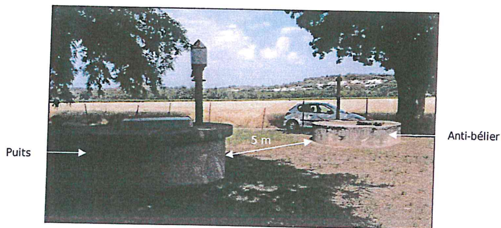
Vue de la tête du puits Brasset et du bâti protégeant l'anti-bélier
