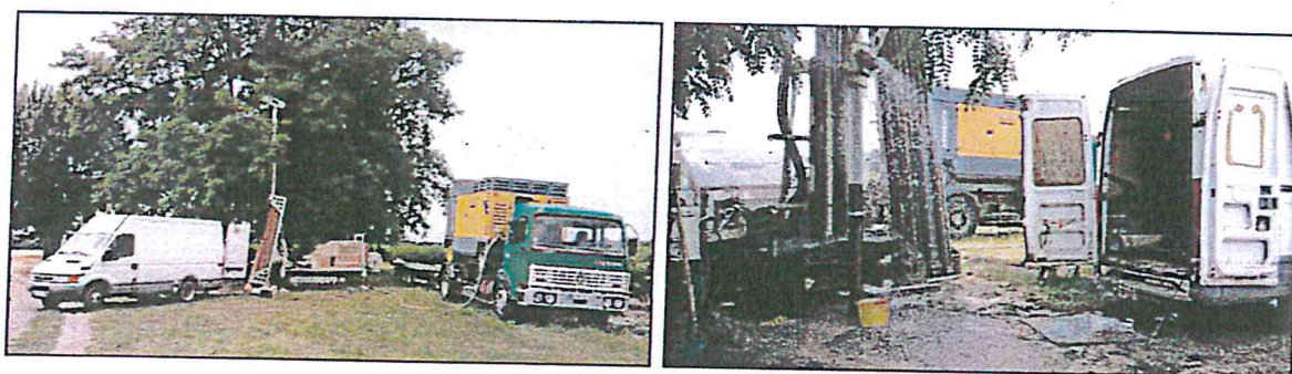
Vue des installations (fourgon, foreuse, compresseur) à gauche, et du soufflage à l'air lift à droite
