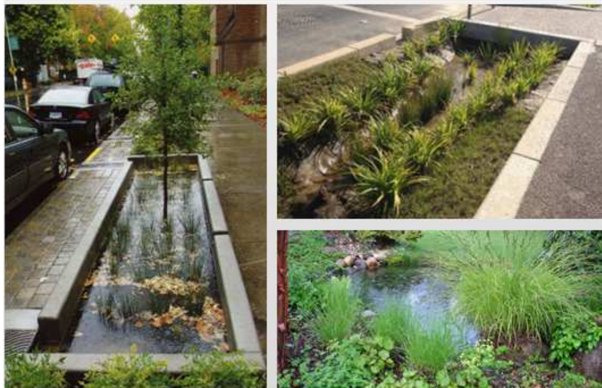
Dispositif de type jardin de pluie permettant l'infiltration et la rétention – Solution à privilégier
