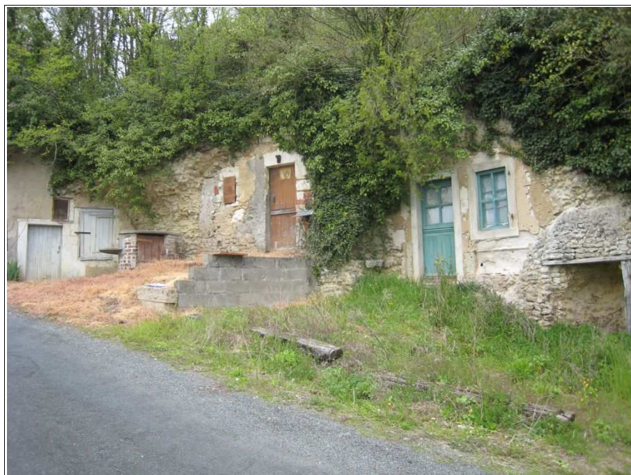
Figure 46 : Zone d'aléa présumé fort : falaise non diagnosticable car masquée (végétation ou maçonnerie) – Vouvray-sur-Loir
