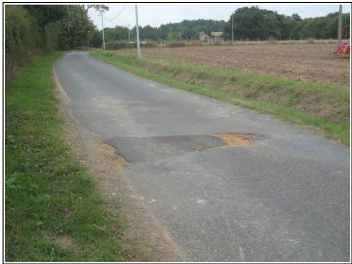
Figure 32 : Désordre remblayé à l'aplomb d'une cavité en plateau - Château-du-Loir
