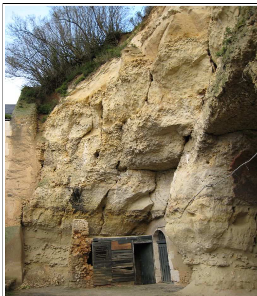
Figure 21 : Discontinuités découpant des écaïlles sur le coteau - Château-du-Loir
