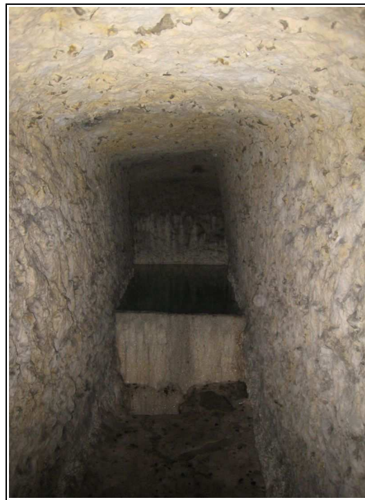
Figure 4 : Captage de la nappe en fond de cave - Vouvray-sur-Loir
