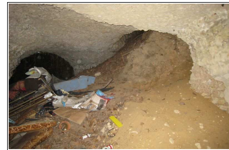
Figure 20 : Cloche de fontis qui a évolué jusqu'en surface - Vouvray-sur-Loir
