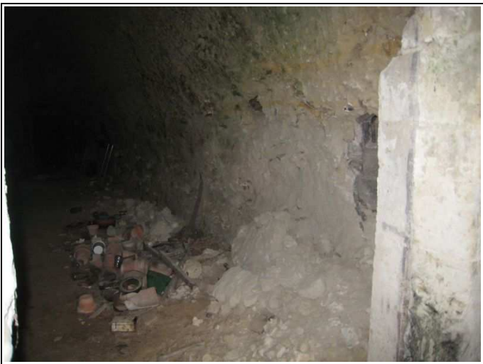
Figure 30 : Chutes pierres et blocs consécutives à l'écaillage du piédroit - Vouvray-sur-Loir
