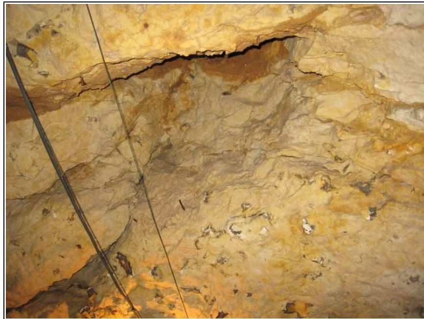
Figure 22 : Réseau de trois discontinuités à l'origine de la chute d'un dièdre rocheux dans une cave - Château-du-Loir
