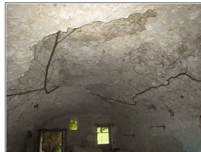
Figure 25 : Décollement de voûte d'une cave sous l'action de racines - Vouvray-sur-Loir
