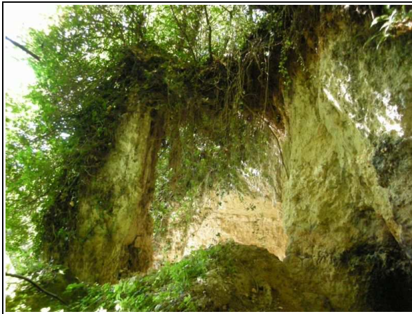
Figure 14 : Rupture en pied de colonne : mécanisme et illustration - Vouvray-sur-Loir
