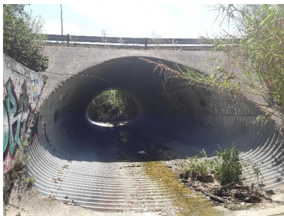
1. Val de Croze - Vue de la face amont de l'ouvrage rue Rouget de Lisle
