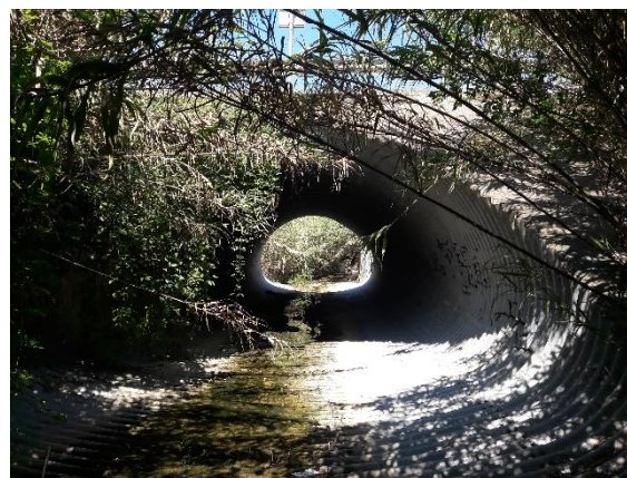
2. Val de Croze - Vue de la face aval de l'ouvrage rue Rouget de Lisle
