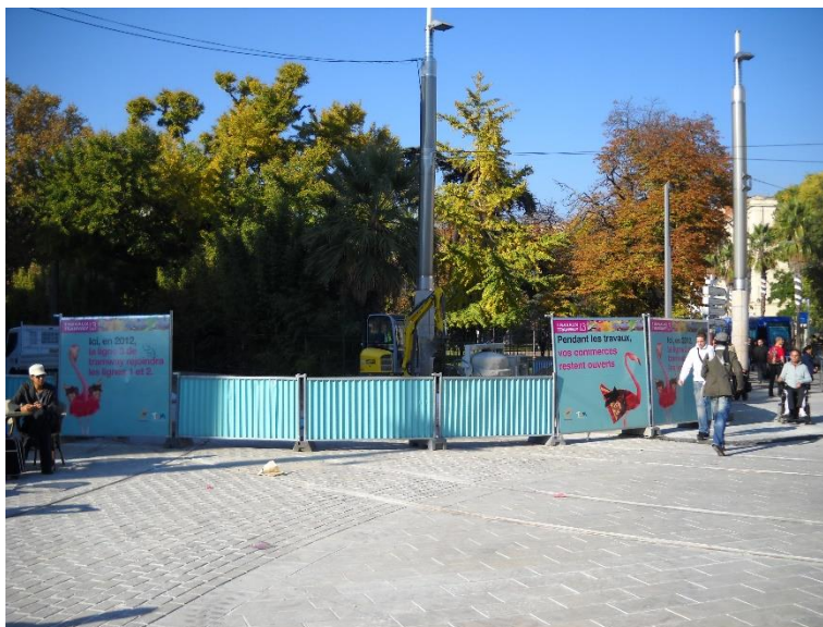
Illustration 1 : Barrière pleine (chantier ligne 3)
