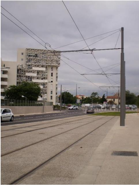
Figure 59: Poteau latéral avec suspension sous console double voie
