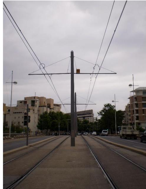
Figure 60: Poteau central avec suspension sous deux consoles simple voie
