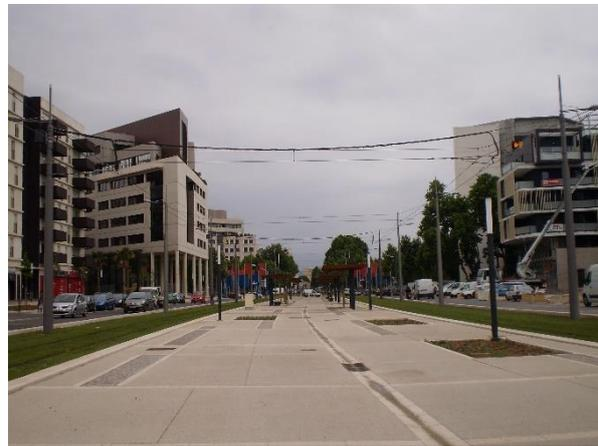
Figure 58: Deux poteaux avec portique souple
