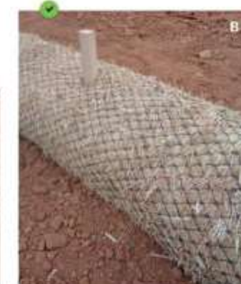
Boudins avec maillage plastique et rembourrage en fibre de paille, ancrés par pieux alternés (A) ou selon la technique "vampire" (B).
