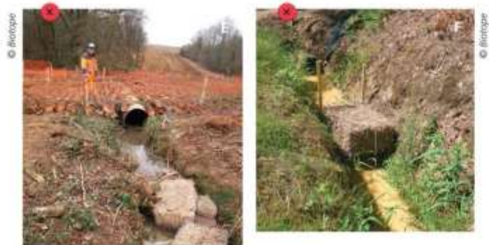
E, F - Bottes de paille insérées dans un gabion et mises en place en aval du point de rejet. La mauvaise installation de ces gabions rend les dispositifs inefficaces voire contre-productifs.
