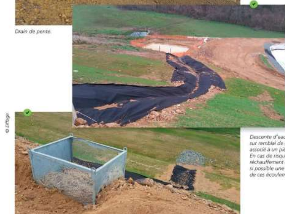
Descente d'eau provisoire sur remblai de grande hauteur, avec passage au travers d'une cage de filtration (en amont) et d'un dispositif anti-érosion (en aval).
