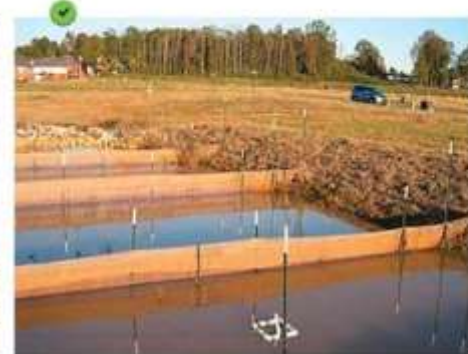
Bassin de décantation dont les talus sont décaissés et végétalisés. Equipement : chicanes en toile de jute fixée à des piquets en acier et vidangeur flottant de type « skimmer ».
