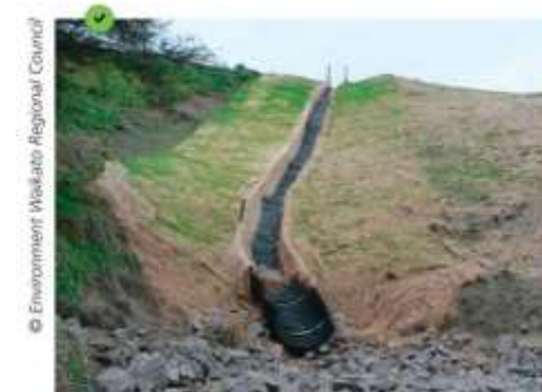
Demi-gaine HDPP sur une surface décapée mais ensemençée et paillée, avec équipement du point de rejet d'un dispositif anti-érosion.
