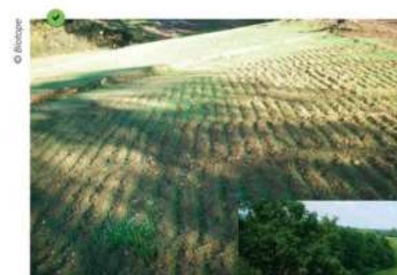
Hydroseeding sur surface préalablement traitée (chenillage des sols et mise en place de cunettes). La germination est visible au creux des empreintes.
