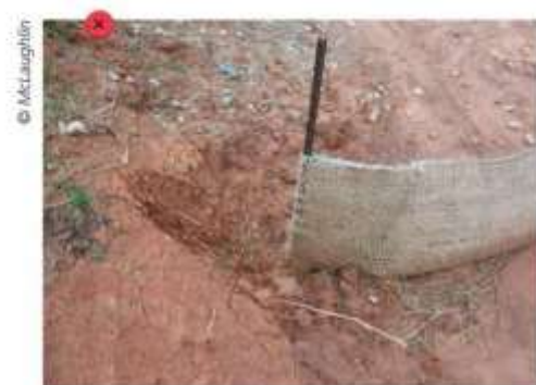
La mauvaise disposition des barrières entraîne des contours irréguliers et des processus d'érosion des talus.
