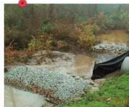
Double barrières de rétention installées à la périphérie de l'emprise du chantier et conjuguées à des boudins en fibres de paille maintenus au sol par des sacs de graviers.
