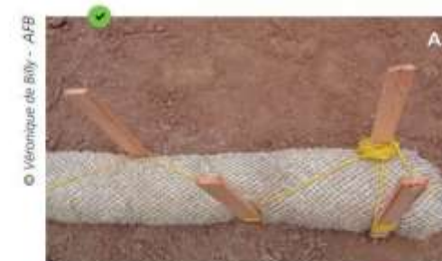
Boudins avec maillage plastique et rembourrage en fibre de paille, ancrés par pieux alternés (A) ou selon la technique "vampire" (B).
