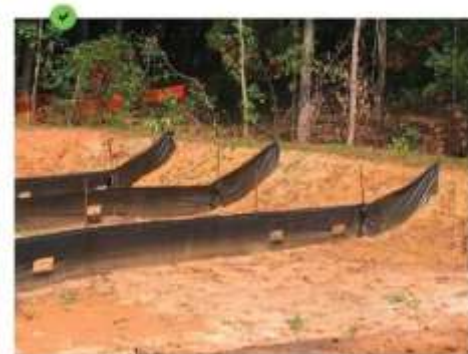
Fixation correcte des barrières géotextiles.
