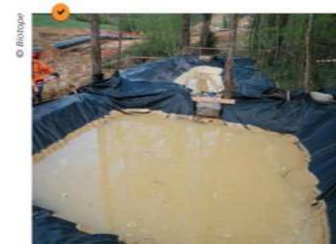
Dispositif de surverse à gabion de paille.
