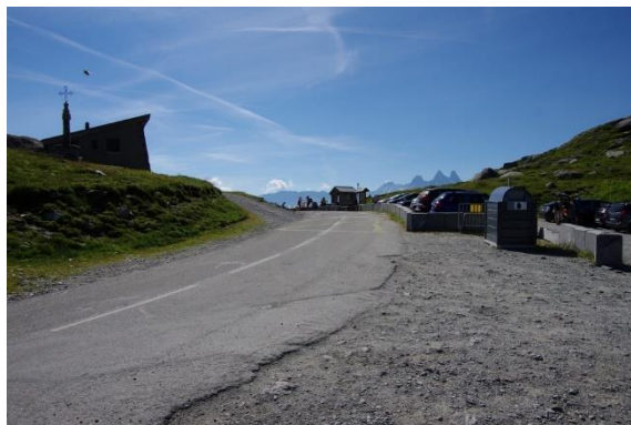
La Croix-de-Fer à gauche, à droite, le parking, le mobilier n'est pas intégré au site et ne le valorise pas
