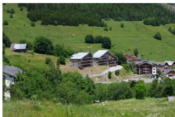
Une expansion du bâti touristique dans la pente, les terrassements sont importants
