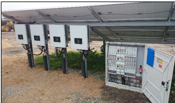
Figure 11 : Exemple d'onduleurs Sungrow et d'une boîte de distribution secondaire (Source : documents internes à l'entreprise)
