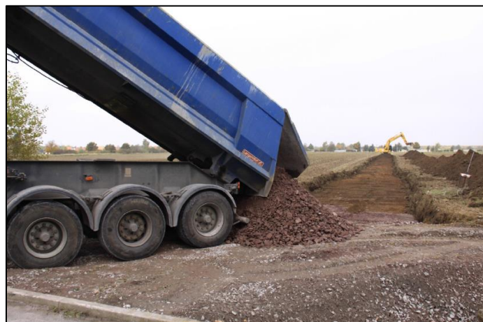
Figure 138 : Remblayage de l'excavation avec du gravier (Source : document interne à l'entreprise)
