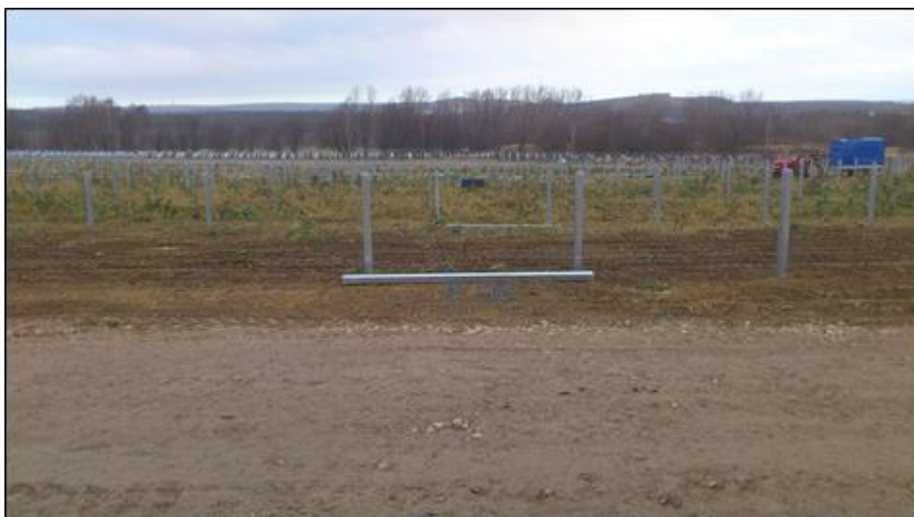
Figure 34 : Enfoncement à la hie des poteaux Sigma – 6 (Source : documents internes à l'entreprise)
