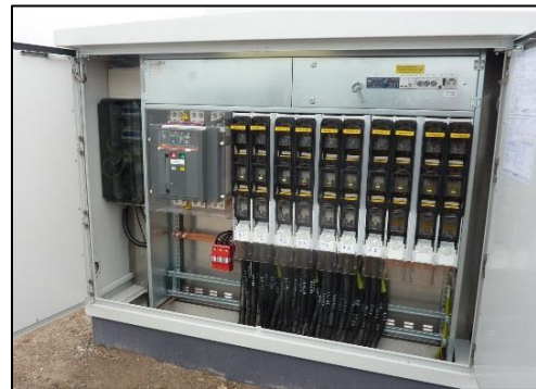
Figure 13 : Exemple de l'intérieur d'un transformateur (Source : documents internes à l'entreprise)
