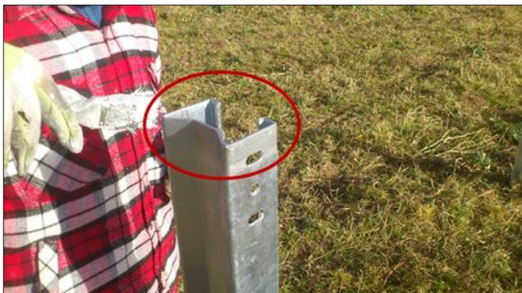
Figure 29 : Enfouissement à la hie des poteaux Sigma – 1 (Source : documents internes à l'entreprise)
