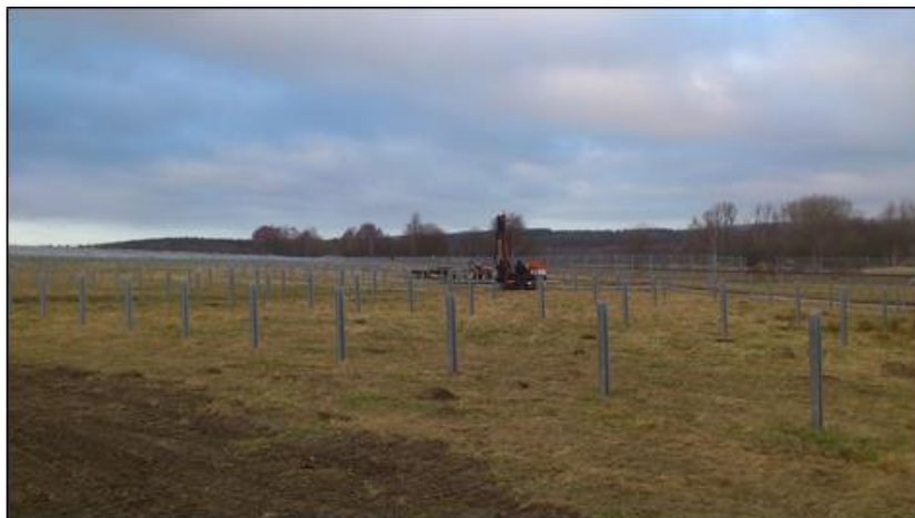
Figure 33 : Enfoncement à la hie des poteaux Sigma – 5 (Source : documents internes à l'entreprise)
