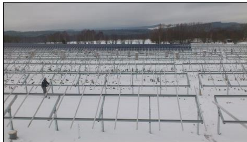
Figure 54 : Montage des supports sur fondation Sigma – 8 (Source : documents internes à l'entreprise)
