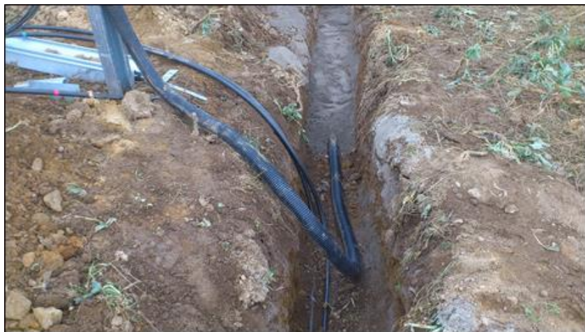
Figure 43 : Fermeture des tranchées – 1 (Source : documents internes à l'entreprise)
