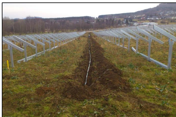
Figure 134 : Réalisation d'un réseau de câbles souterrain (Source : document interne à l'entreprise)
