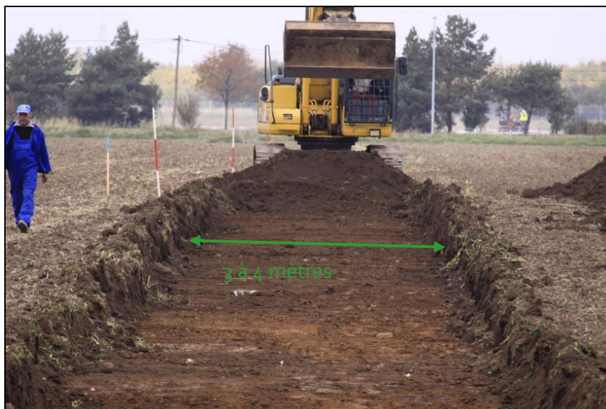
Figure 137 : Réalisation des excavations pour les chemins d'accès sur le site du parc photovoltaïque à Sietzsch - profondeur de l'excavation dans ce cas : 0,8 mètres (Source : document interne à l'entreprise)
