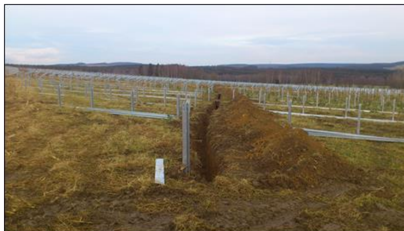
Figure 36 : Réalisation des tranchées de passage des câbles – 1 (Source : documents internes à l'entreprise)
