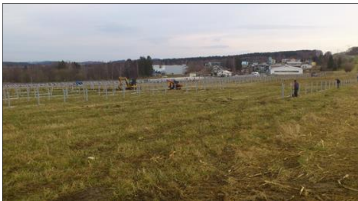
Figure 30 : Enfouissement à la hie des poteaux Sigma – 2 (Source : documents internes à l'entreprise)
