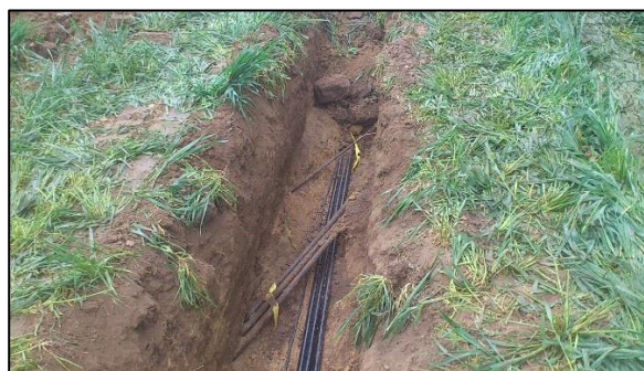
Figure 147: Enfouissement des câbles de raccordement – 2 (Source : documents internes à l'entreprise)
