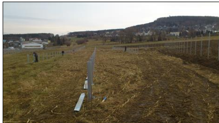
Figure 32 : Enfouissement à la hie des poteaux Sigma – 4 (Source : documents internes à l'entreprise)
