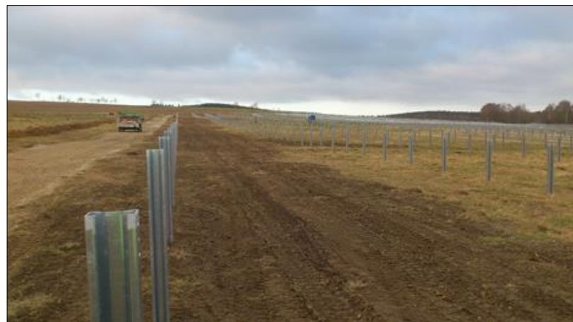
Figure 35 : Enfoncement à la hie des poteaux Sigma – 7 (Source : documents internes à l'entreprise)
