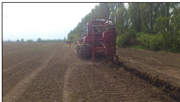
Figure 146: Enfouissement des câbles de raccordement (Source : documents internes à l'entreprise)
