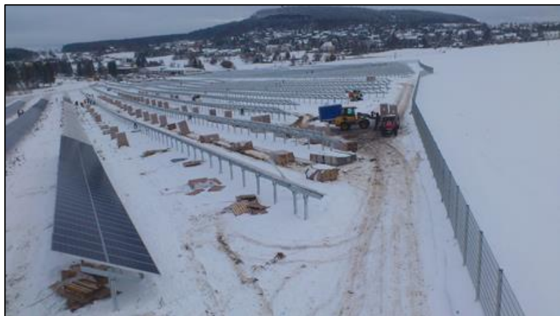
Figure 56 : Installation des panneaux – 2 (Source : documents internes à l'entreprise)
