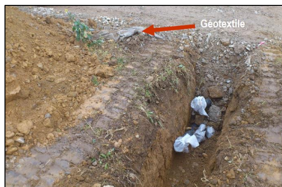
Figure 135 : Fermeture des tranchées (Source : document interne à l'entreprise)
