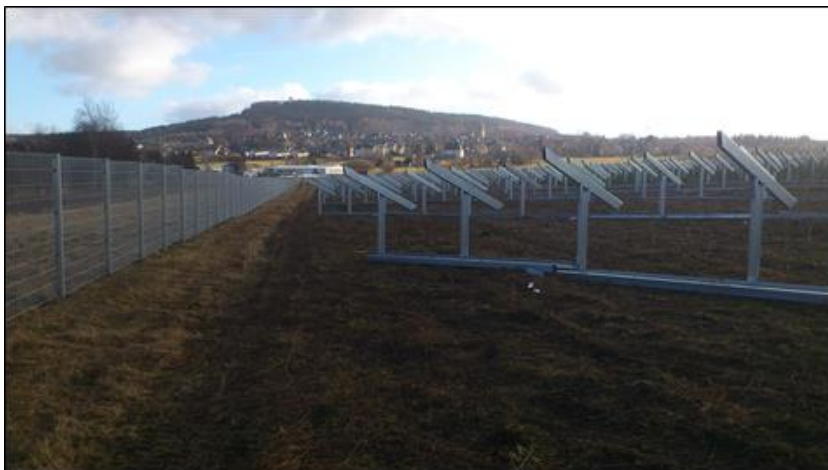
Figure 48 : Montage des supports sur fondation Sigma – 2 (Source : documents internes à l'entreprise)
