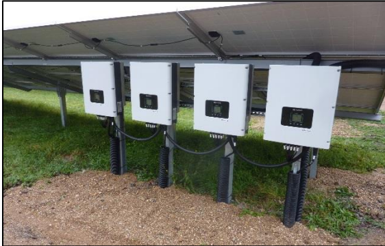
Figure 10 : Exemple d'onduleurs Sungrow (Source : documents internes à l'entreprise)
