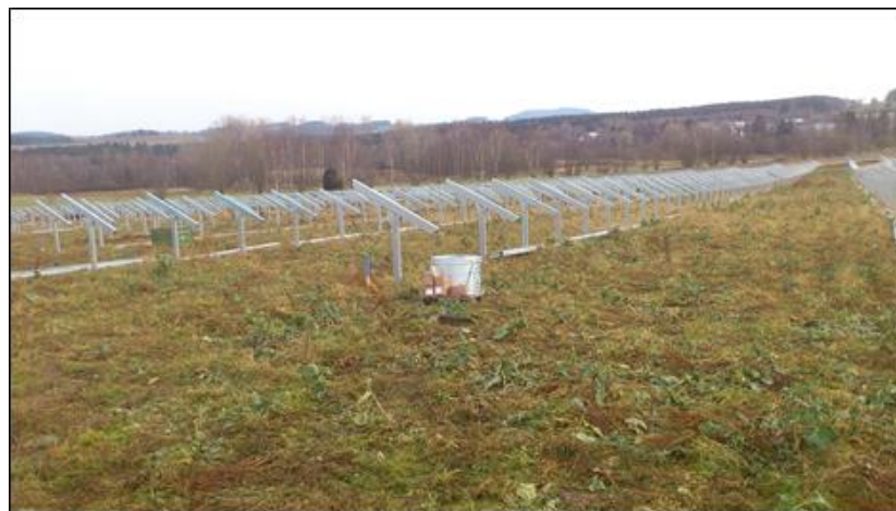
Figure 50 : Montage des supports sur fondation Sigma – 4 (Source : documents internes à l'entreprise)
