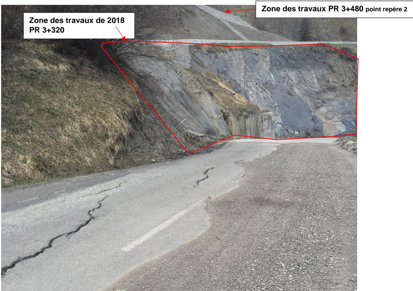
**Photo 6** : repère 6 sur la figure 1 chaussée RD78A fissurée.
