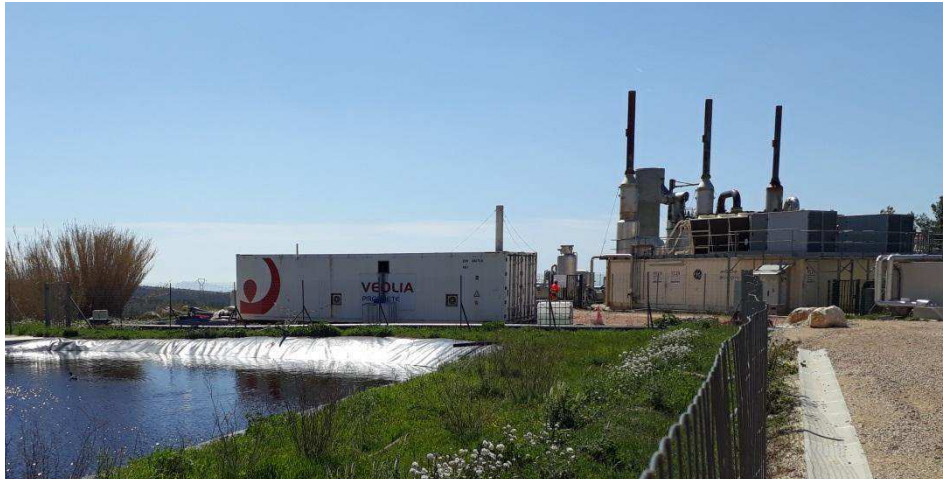
Photo 26 : Traitement des lixiviats par Osmose Inverse
