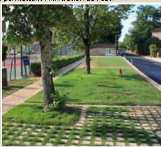
Exemple de dispositif permettant l'infiltration de l'eau sur des places de stationnement
