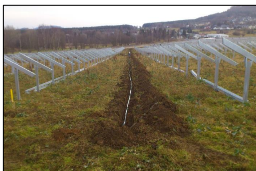
Figure 115 : Réalisation d'un réseau de câbles souterrain (Source : document interne à l'entreprise)
