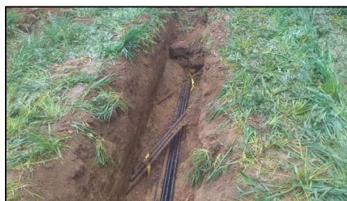
Figure 129 : Enfouissement des câbles de raccordement – 2 (Source : documents internes à l'entreprise)
