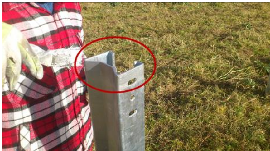
Figure 26 : Enfouissement à la hie des poteaux Sigma – 1 (Source : documents internes à l'entreprise)
