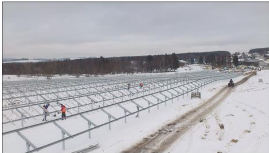
Figure 49 : Montage des supports sur fondation Sigma – 6 (Source : documents internes à l'entreprise)
