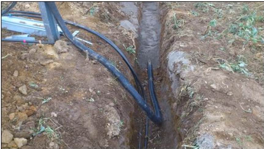
Figure 40 : Fermeture des tranchées – 1 (Source : documents internes à l'entreprise)
