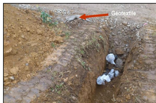
Figure 116 : Fermeture des tranchées (Source : document interne à l'entreprise)
