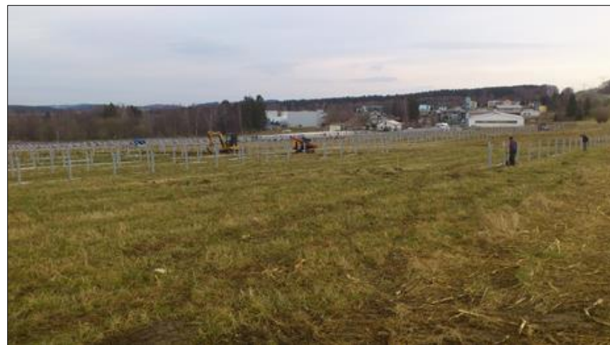
Figure 27 : Enfouissement à la hie des poteaux Sigma – 2 (Source : documents internes à l'entreprise)
