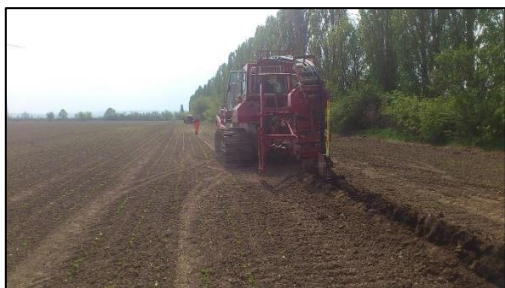
Figure 128 : Enfouissement des câbles de raccordement (Source : documents internes à l'entreprise)
