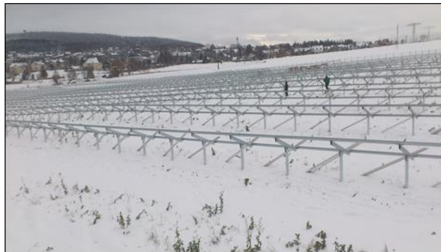
Figure 50 : Montage des supports sur fondation Sigma – 7 (Source : documents internes à l'entreprise)
