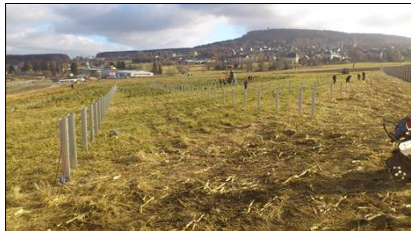
Figure 28 : Enfoncement à la hie des poteaux Sigma – 3 (Source : documents internes à l'entreprise)
