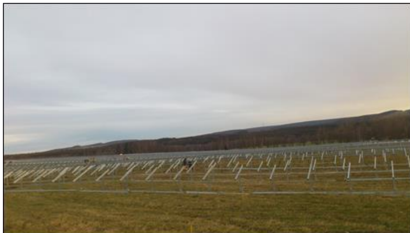
Figure 48 : Montage des supports sur fondation Sigma – 5 (Source : documents internes à l'entreprise)
