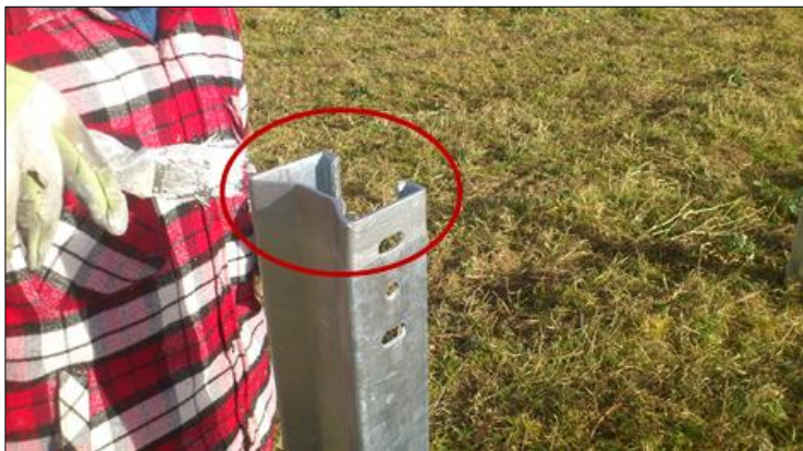
Figure 26 : Enfoncement à la hie des poteaux Sigma – 1 (Source : documents internes à l'entreprise)
