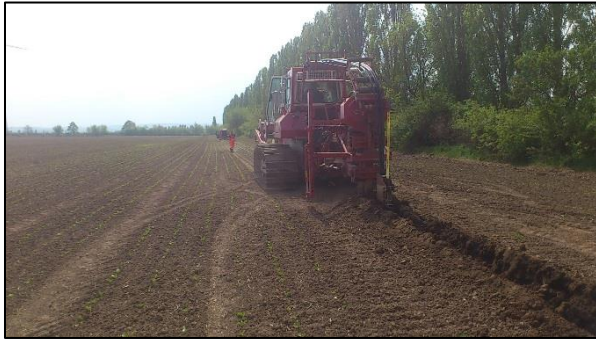
Figure 136: Enfouissement des câbles de raccordement (Source : documents internes à l'entreprise)
