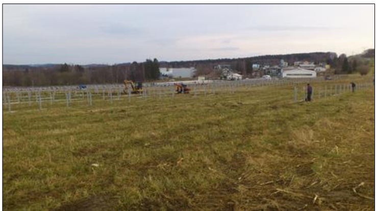
Figure 27 : Enfoncement à la hie des poteaux Sigma – 2 (Source : documents internes à l'entreprise)
