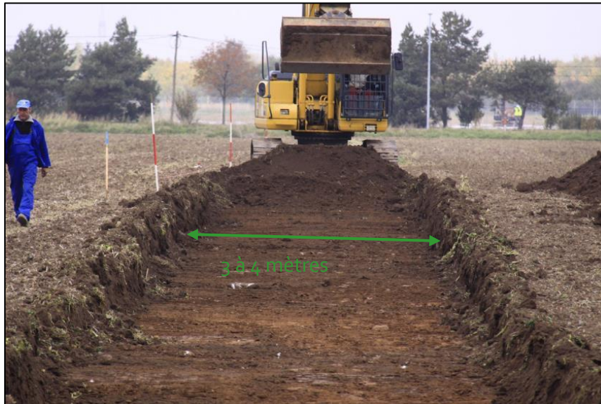
Figure 127 : Réalisation des excavations pour les chemins d'accès sur le site du parc photovoltaïque à Sietzsch - profondeur de l'excavation dans ce cas : 0,8 mètres (Source : document interne à l'entreprise)
