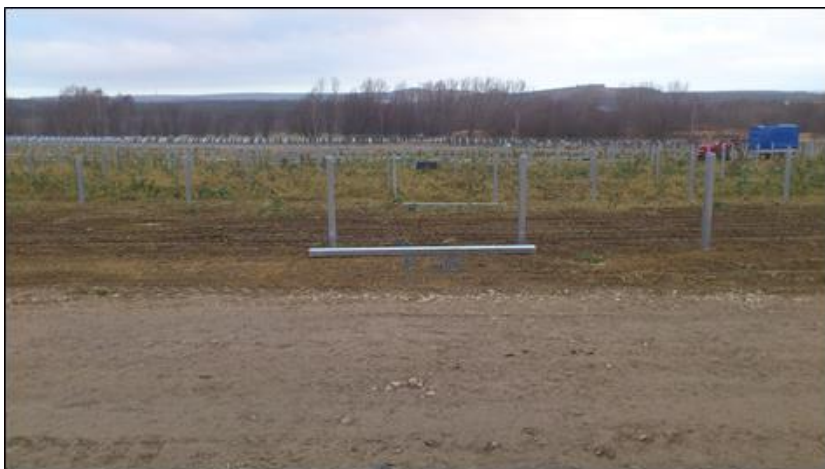
Figure 31 : Enfoncement à la hie des poteaux Sigma – 6 (Source : documents internes à l'entreprise)
