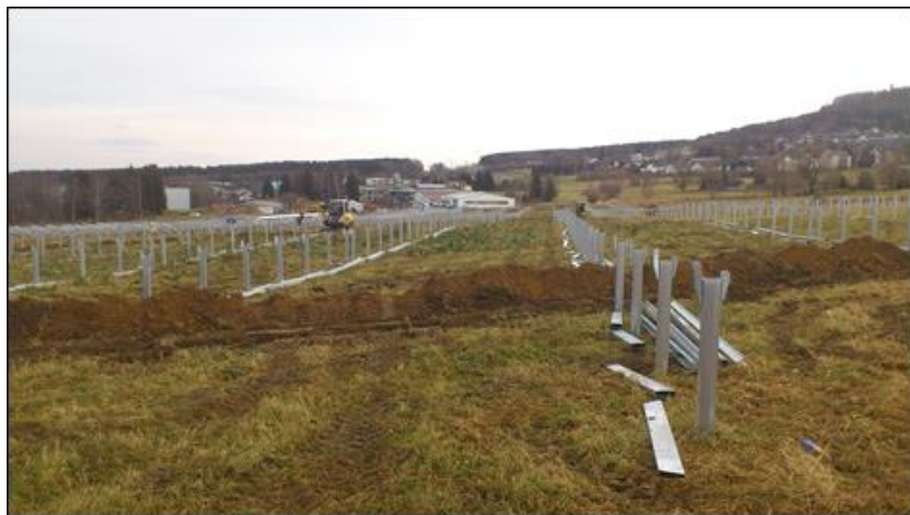
Figure 34 : Réalisation des tranchées de passage des câbles – 2 (Source : documents internes à l'entreprise)
