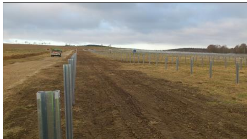
Figure 32 : Enfoncement à la hie des poteaux Sigma – 7 (Source : documents internes à l'entreprise)
