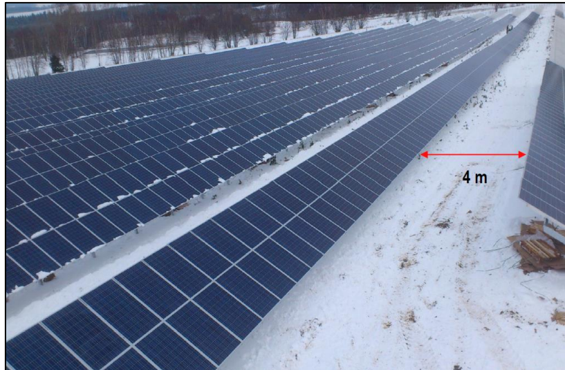
Figure 132 : Espace entre les rangées de tables photovoltaïques (Source : document interne à l'entreprise)
