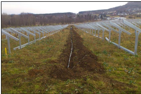
Figure 124 : Réalisation d'un réseau de câbles souterrain (Source : document interne à l'entreprise)
