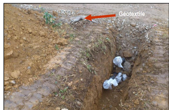
Figure 125 : Fermeture des tranchées (Source : document interne à l'entreprise)
