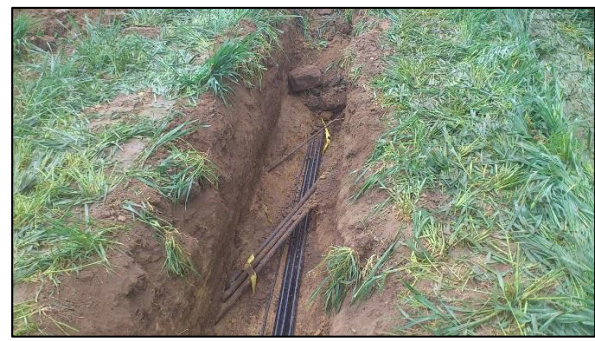
Figure 137: Enfouissement des câbles de raccordement – 2 (Source : documents internes à l'entreprise)
