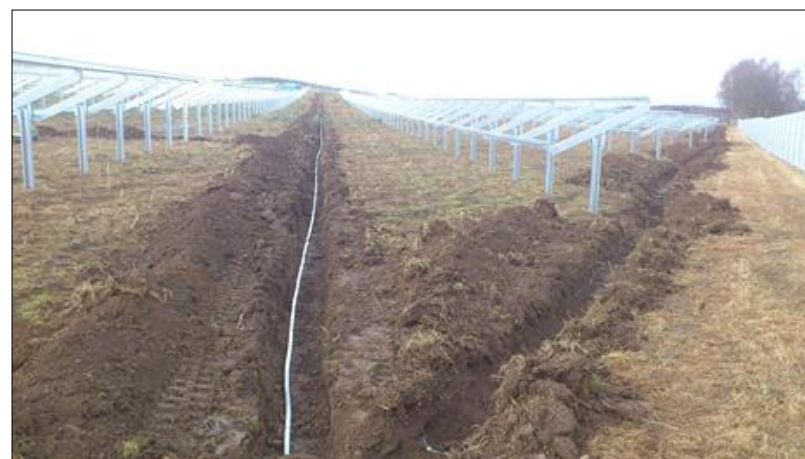
Figure 37 : Réalisation du réseau souterrain – 1 (Source : documents internes à l'entreprise)
