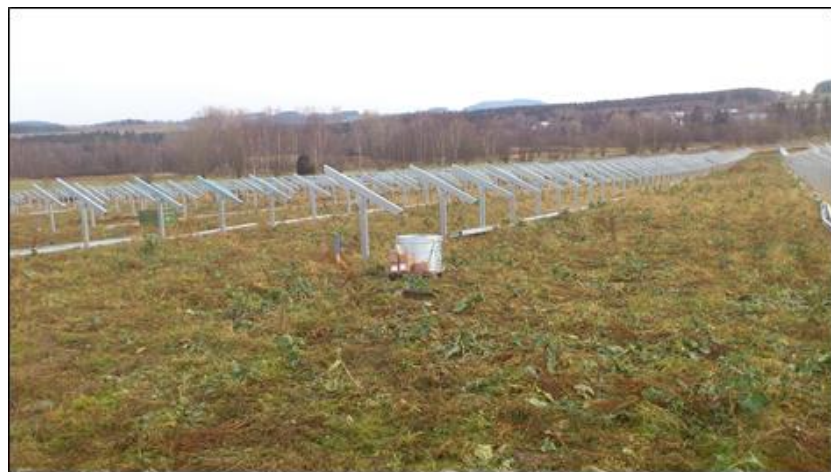
Figure 47 : Montage des supports sur fondation Sigma – 4 (Source : documents internes à l'entreprise)
