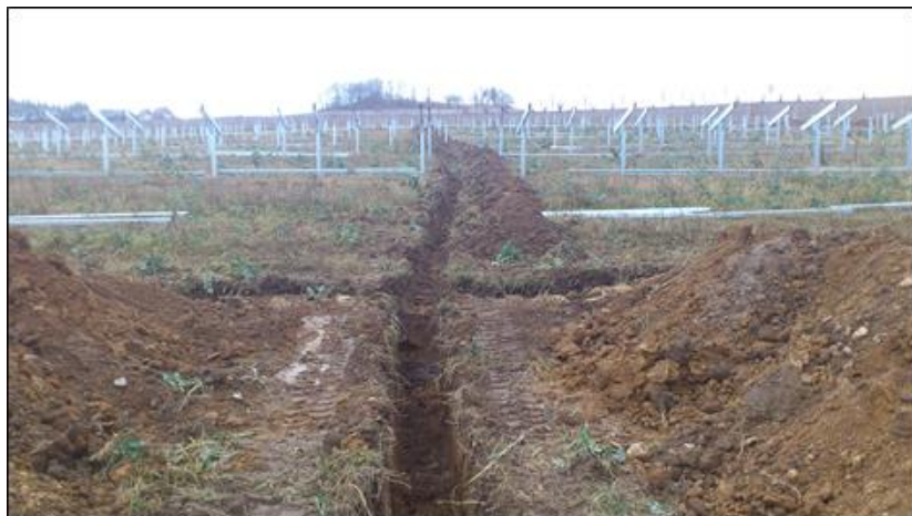
Figure 35 : Réalisation des tranchées de passage des câbles – 3 (Source : documents internes à l'entreprise)
