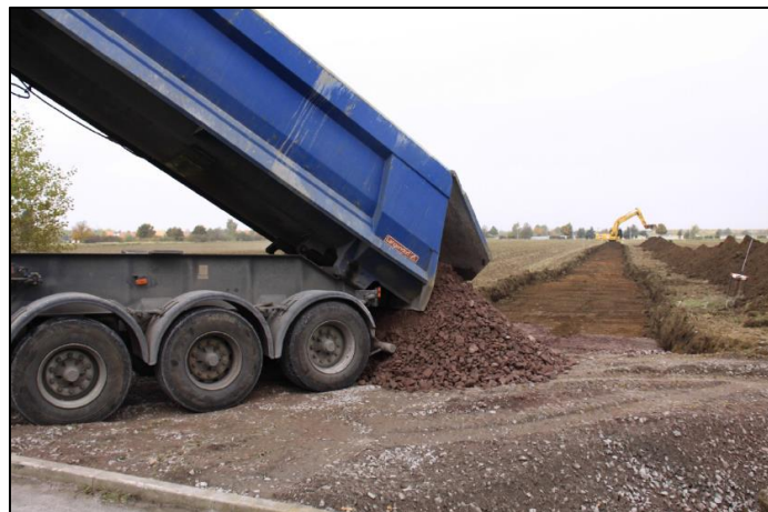
Figure 128 : Remblayage de l'excavation avec du gravier (Source : document interne à l'entreprise)
