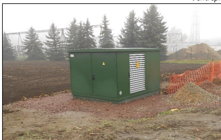
Figure 12 : Exemple d'un poste de livraison (Source : documents internes à l'entreprise)
