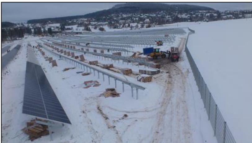
Figure 53 : Installation des panneaux – 2 (Source : documents internes à l'entreprise)
