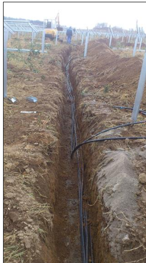
Figure 39 : Réalisation du réseau souterrain – 3 (Source : documents internes à l'entreprise)
