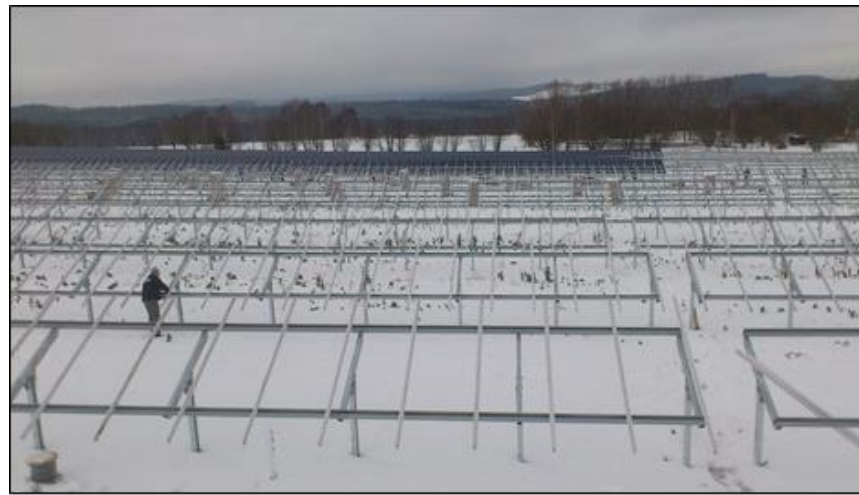
Figure 51 : Montage des supports sur fondation Sigma – 8 (Source : documents internes à l'entreprise)
