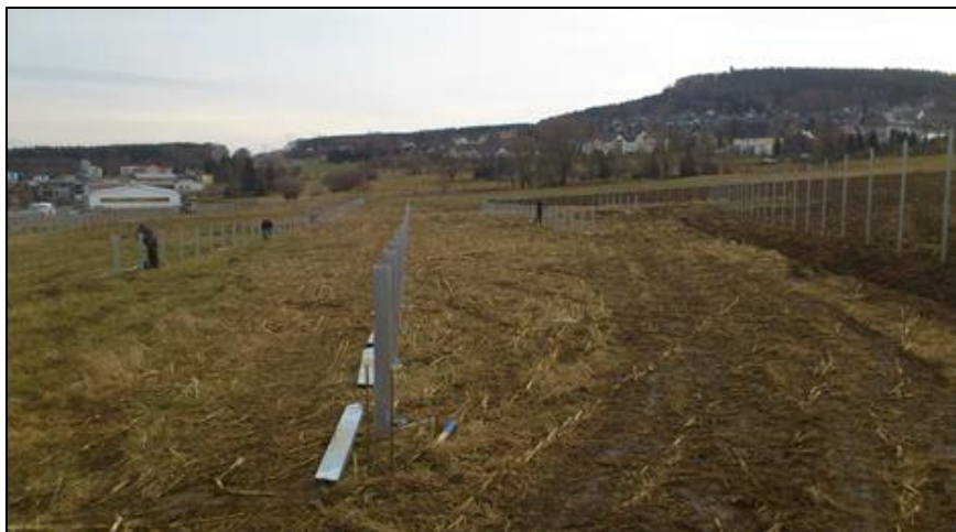
Figure 29 : Enfoncement à la hie des poteaux Sigma – 4 (Source : documents internes à l'entreprise)
