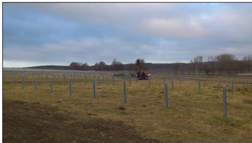
Figure 30 : Enfoncement à la hie des poteaux Sigma – 5 (Source : documents internes à l'entreprise)
