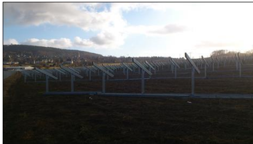
Figure 46 : Montage des supports sur fondation Sigma – 3 (Source : documents internes à l'entreprise)
