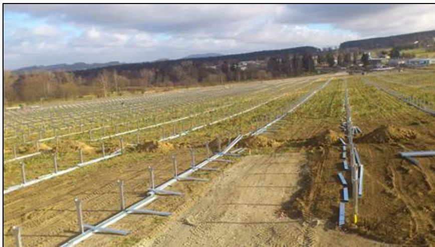
Figure 44 : Montage des supports sur fondation Sigma – 1 (Source : documents internes à l'entreprise)
