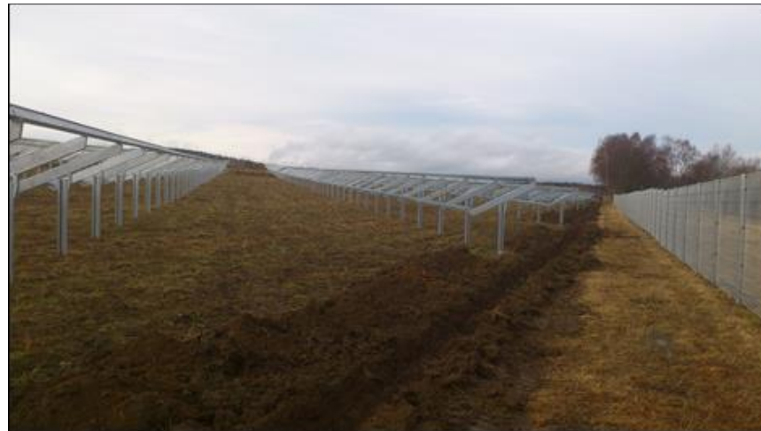
Figure 36 : Réalisation des tranchées de passage des câbles – 4 (Source : documents internes à l'entreprise)
