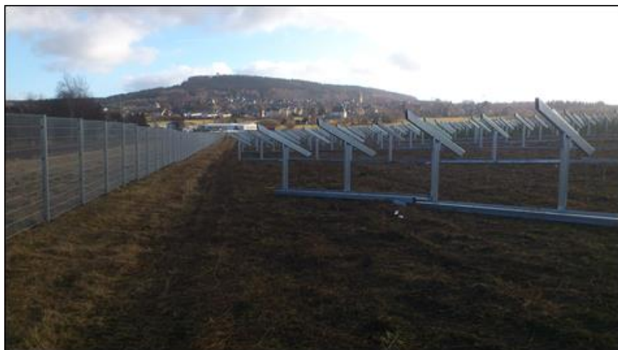
Figure 45 : Montage des supports sur fondation Sigma – 2 (Source : documents internes à l'entreprise)
