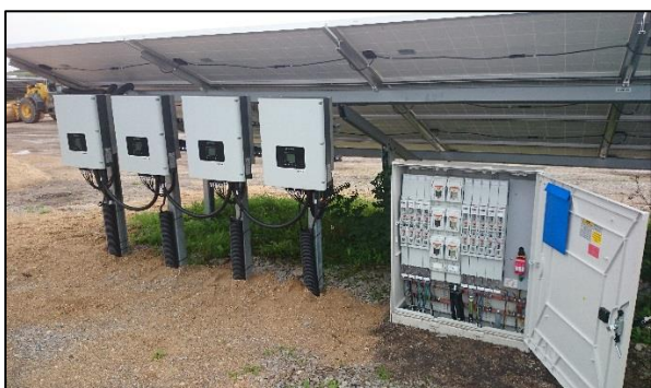
Figure 9 : Exemple d'onduleurs string et d'une boîte de distribution secondaire (Source : documents internes à l'entreprise)
