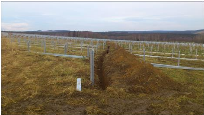
Figure 33 : Réalisation des tranchées de passage des câbles – 1 (Source : documents internes à l'entreprise)
