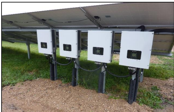
Figure 8 : Exemple d'onduleurs string (Source : documents internes à l'entreprise)
