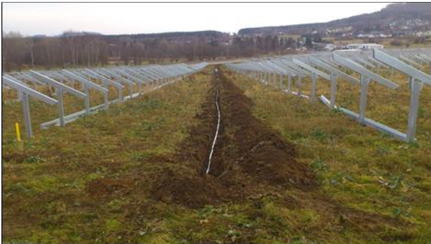
Figure 38 : Réalisation du réseau souterrain – 2 (Source : documents internes à l'entreprise)
