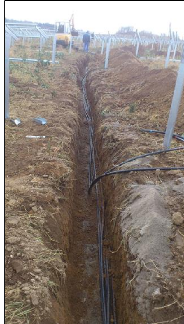
Figure 39 : Réalisation du réseau souterrain – 3 (Source : documents internes à l'entreprise)
