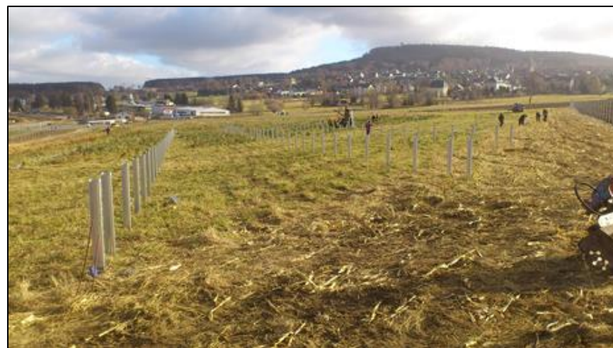
Figure 28 : Enfouissement à la hie des poteaux Sigma – 3 (Source : documents internes à l'entreprise)
