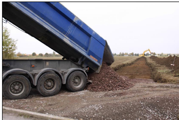
Figure 119 : Remblayage de l'excavation avec du gravier (Source : document interne à l'entreprise)
