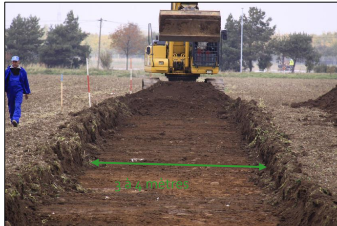
Figure 118 : Réalisation des excavations pour les chemins d'accès sur le site du parc photovoltaïque à Sietzsch - profondeur de l'excavation dans ce cas : 0,8 mètres (Source : document interne à l'entreprise)
