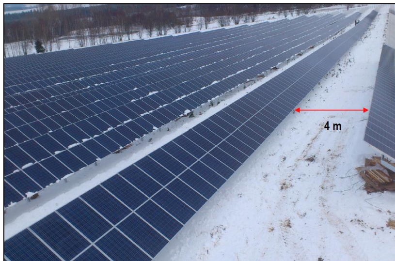
Figure 123 : Espace entre les rangées de tables photovoltaïques (Source : document interne à l'entreprise)
