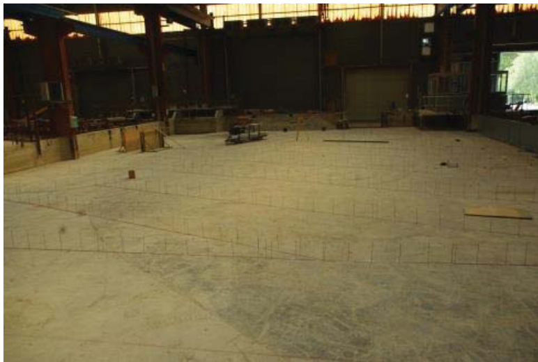
Etape 1: Implantation et Mise en place des piges de nivellement des isobathes
