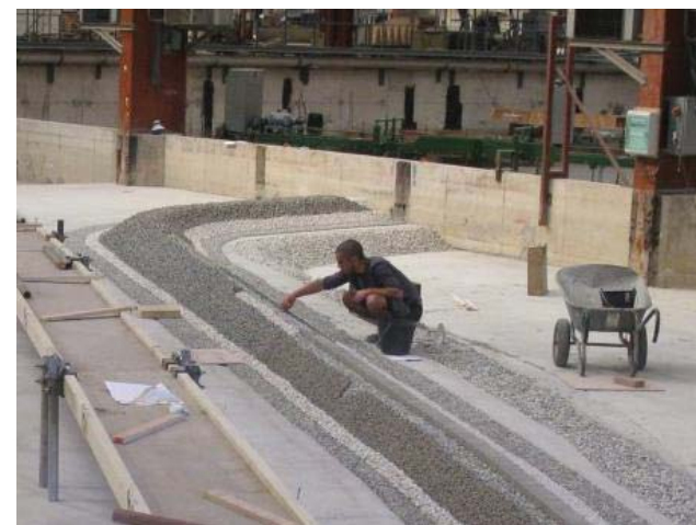
Etape 6: Mise en place des blocs de carapace posés un par un (12 000 unités) et des murs de couronnement
