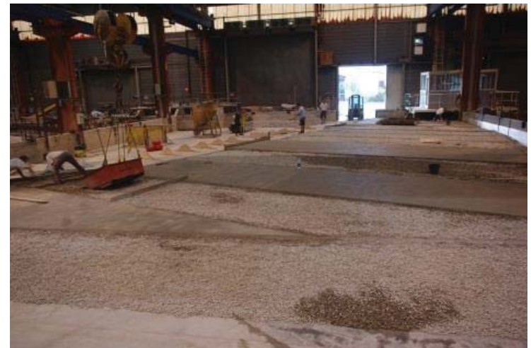
Etape 2: Remplissage par des gravettes et début de construction des fonds (chape béton)
