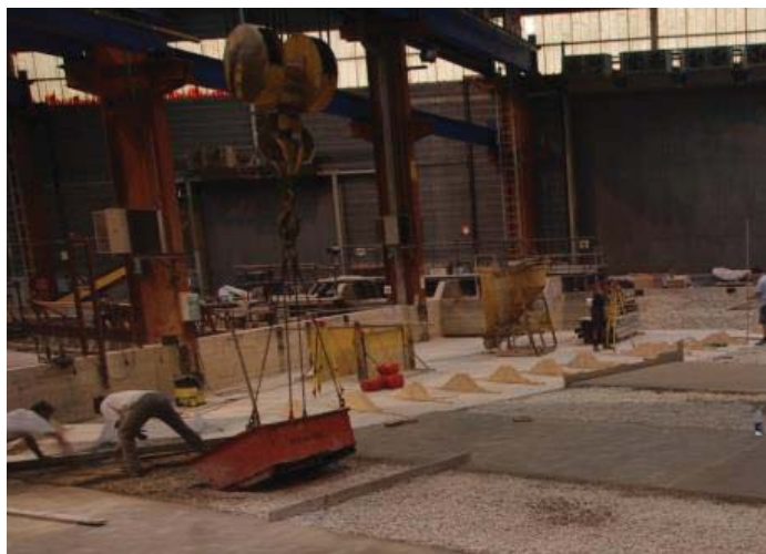
Etape 3: Début de construction de la digue avec mise en place des gabarits
