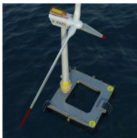
Figure 14 : Flotteur béton « damping pool® » (source Ideol)
