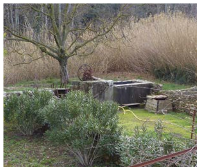
Pompe à eau à manivelle permettant de remonter l'eau depuis la nappe de l'Orb et de la déverser dans un bassin mitoyen appelé tane (chemin de Campesca)
