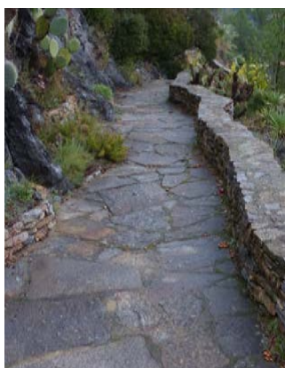
Le traitement des allées du jardin méditerranéen en dalles de schiste posées en opus incertum bordées de petits parapets en pierres dessinent un ensemble parfaitement intégré au paysage de Roquebrun
