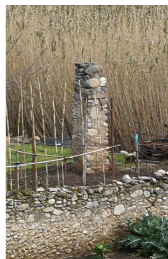
Pivot central construit en galets de l'Orb, dispositif central du système de puit à balancier ou chadouf le long du chemin de Campesca
