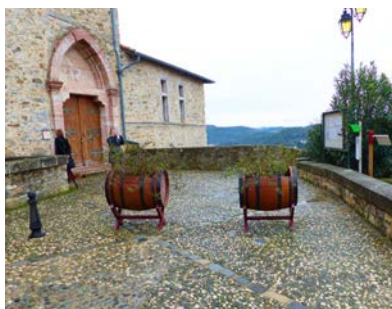
Place de l'église en béton désactivé doté de gros granulats clairs et structurée par des lignes de pavés
