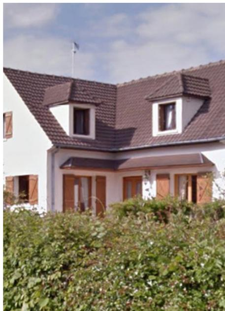
Toiture à deux pans, tuiles mécaniques.
