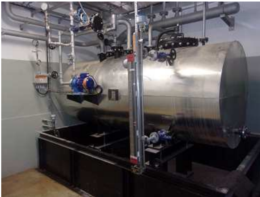
Figure 1: Fosse étanche et cuve de rétention de l'huile thermique
