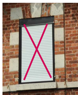
La suppression des volets battant altère les constructions de qualité (gonds et arrêts de volets encore en place).
