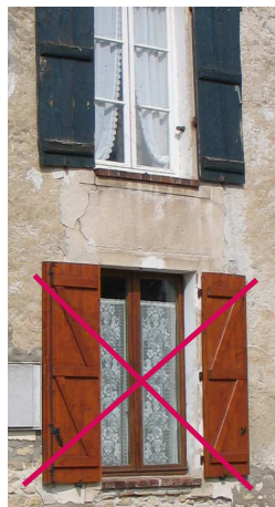
Fenêtre et volets du rez-de-chaussée modifiés sans cohérence avec le dessin d'origine encore présent au 1er étage.
