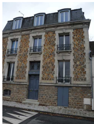
Maison de ville sur RdC surélevé à 3 trames en maçonnerie de pierre meulière ; le comble sous brisis constitue un véritable étage d'habitation.
