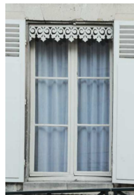
Présence d'un lambrequin en métal découpé : cet élément décoratif peut être employé pour masquer des coffres de volets roulants en saillie présents avant la mise en place de l'AVAP.
