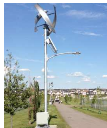
Eolienne à axe vertical, couplée à un panneau photovoltaïque pour l'éclairage public.
