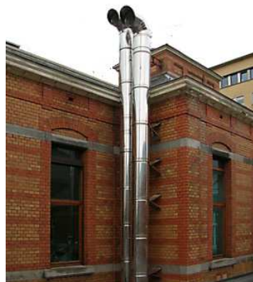
Exemple de conduit de fumée pour chaudière biomasse bois
