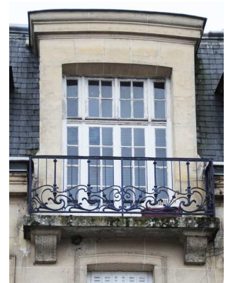
Fenêtre d'une maison de style Eclectique : grande largeur et nombreuses divisions du vitrage, imposte assortie. A noter : le linteau en pierre est façonné en courbe à l'extérieur mais droit au niveau de la fenêtre pour simplifier le travail de menuiserie.
