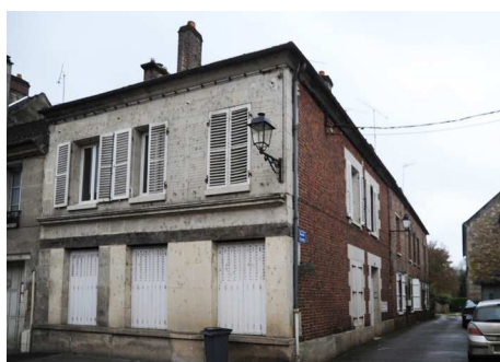
Façade de brique sur une ruelle : la référence à l'habitat ouvrier des Hauts-de-France est peu fréquente ; la brique est utilisée pour son faible coût de fourniture et sa facilité de transport.
