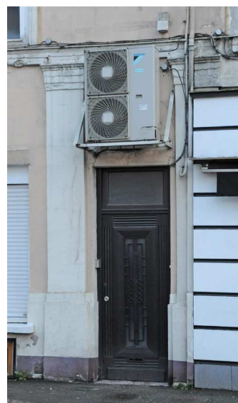
Installation inappropriée de pompes à chaleur en façade (exemple hors département).
