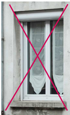
Fenêtre sans division et avec volet roulant.
