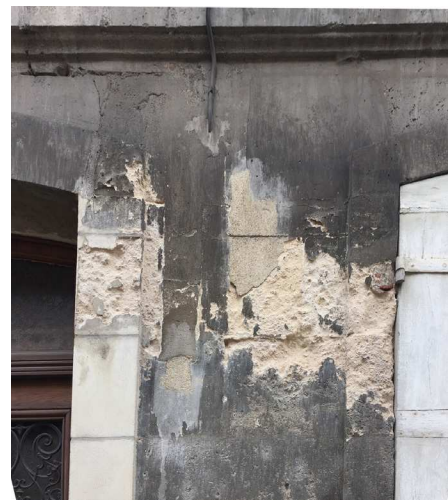
Exemple d'un enduit sur pierre appareillée inadapté (au ciment) = la pierre se désagrége sous l'effet de l'humidité emprisonnée.
