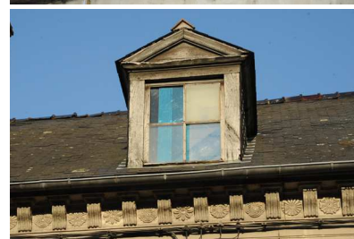
En haut : lucarnes d'éclairage de combles, à croupe et vantaux ouvrant en bois.
