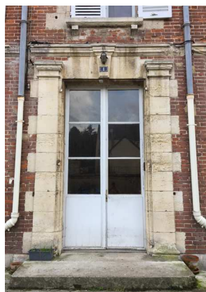
Détail d'un encadrement de porte-fenêtre en maçonnerie de pierre calcaire taillée insérée dans le mur porteur en brique.
