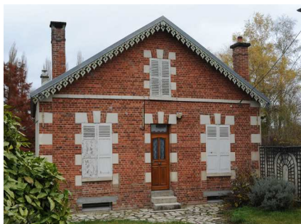
Brique et éléments de pierre pour la totalité d'un pavillon début XXe.
