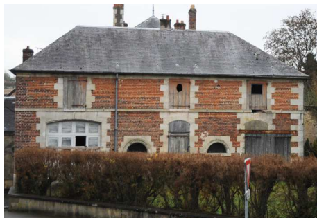
Remplissage de brique, encadrements de pierre de taille pour une construction néo-classique.
