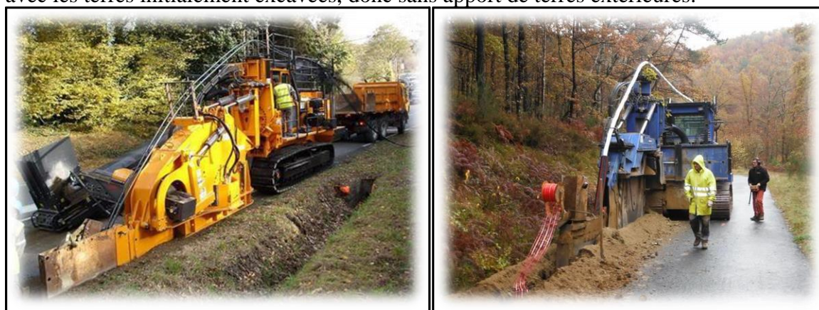
Trancheuse / Exemple de pose de câble à la trancheuse (Source : NEOEN)
