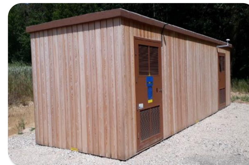
Figure 12 : Exemple de poste de livraison
