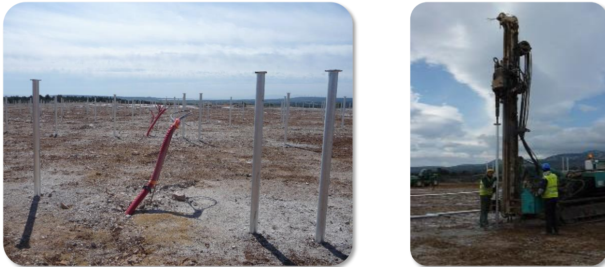
Figure 18 : Exemple d'ancrages type pieux battus
