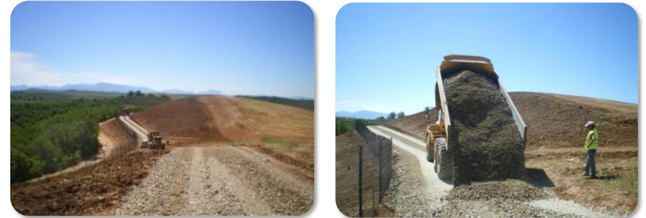
Figure 17 : Exemple de création de voies d'accès
