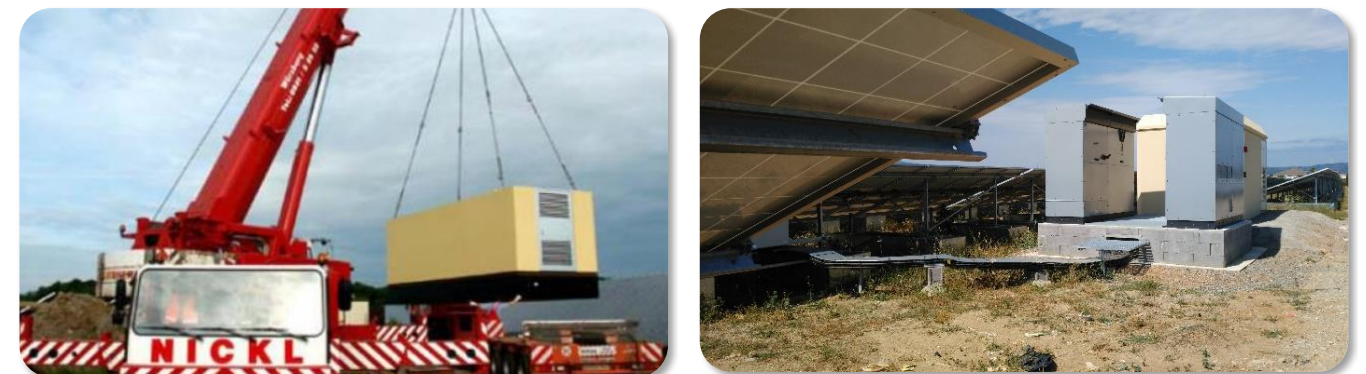
Figure 20 : Exemple d'installation des locaux techniques
