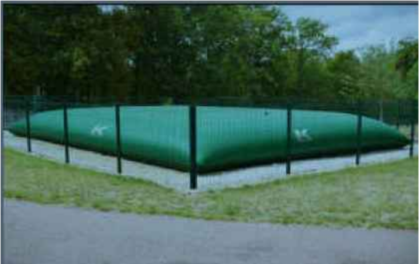
Exemple de réserve incendie 120m³ (Source Kailher)
