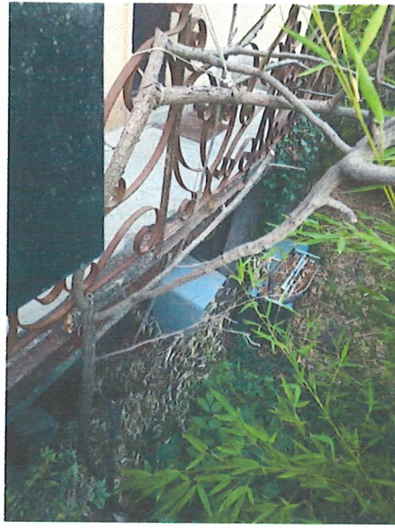
Espace entre maison et pont Encombrant sous la maison
