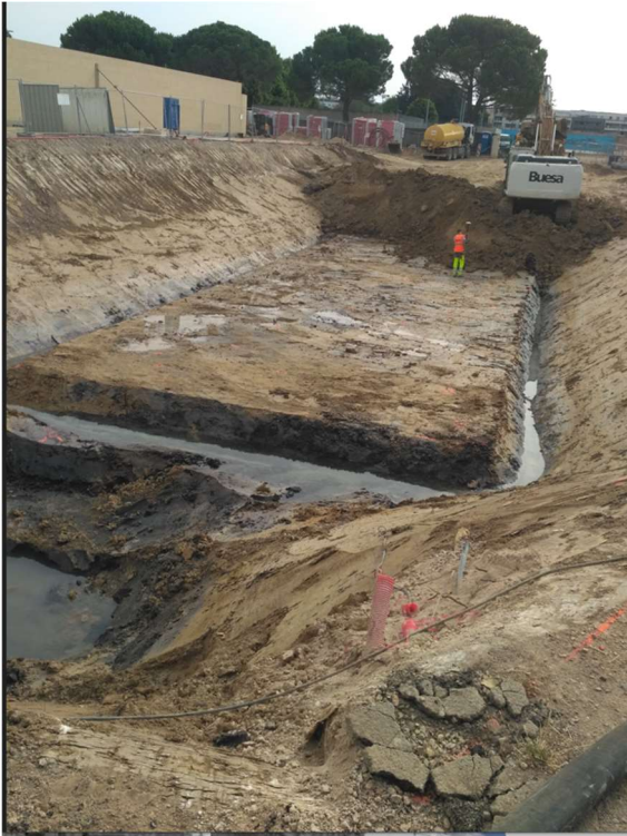
PHOTOS CHANTIER ECOLE JACQUES CHIRAC PRISE LE 15 JUIL 2022
