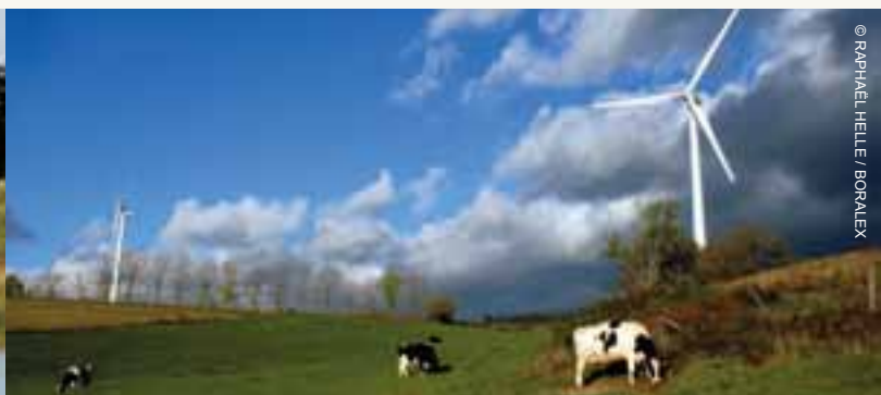
Eoliennes à Ally, Haute-Loire. Les 26 machines génèrent annuellement 78 GWh, près de deux fois la production du barrage de Poutès sur l'Allier.
